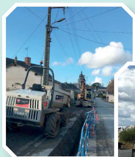
▲ Photo avant travaux
