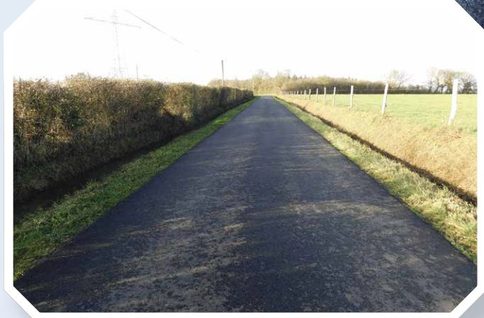
▲ Travaux de voirie en campagne (nord de la commune)
