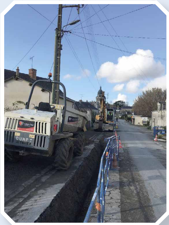
▲ Enfouissement des réseaux rue des Sencies
