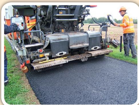
**Travaux de voirie** (chemins ruraux de la Sourcinière, des Grands Cormiers, et VC 3 en direction du Buret). Un essai a été réalisé sur des chemins particulièrement dégradés avec l'application d'un enrobé à froid.
