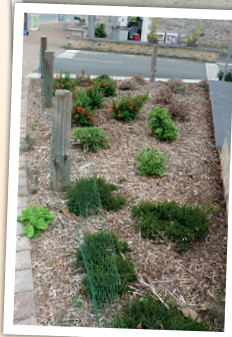
Travaux réalisés par nos agents communaux
