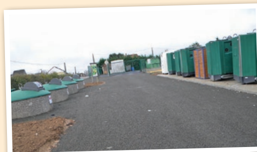
Les travaux d'agrandissement et de réaménagement de la déchetterie par la Communauté de Communes sont terminés
