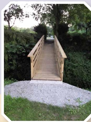
Régulièrement, les services techniques réalisent une vérification de cette passerelle. Au printemps, il s'est avéré que celle-ci était devenue dangereuse. Une nouvelle a donc été fabriquée en interne avec une base en poutrelle acier pour plus de solidité.
